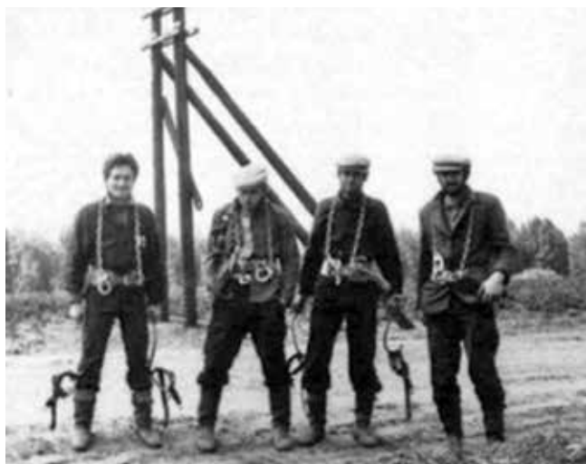
Бригада монтажників повітряних ліній зв'язку: бригадир Сацюк В. (Тюмень, Новотарманськ, 1982 р.)
