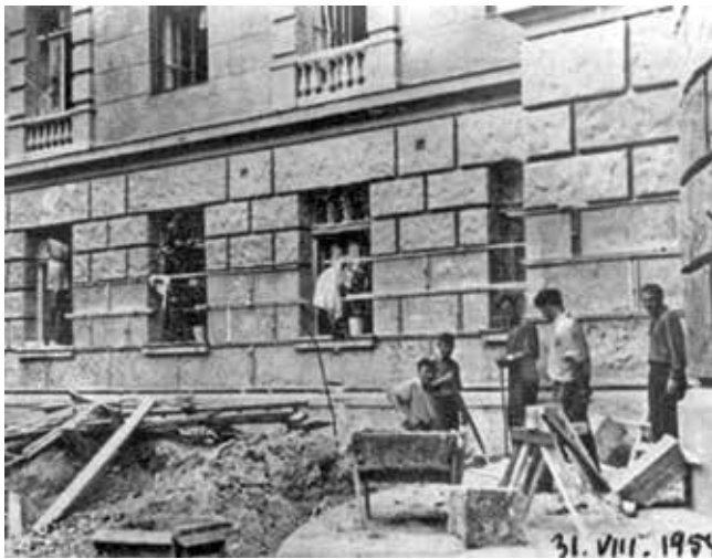
Будівництво головного навчального корпусу по вул. Челюскінців, 1
