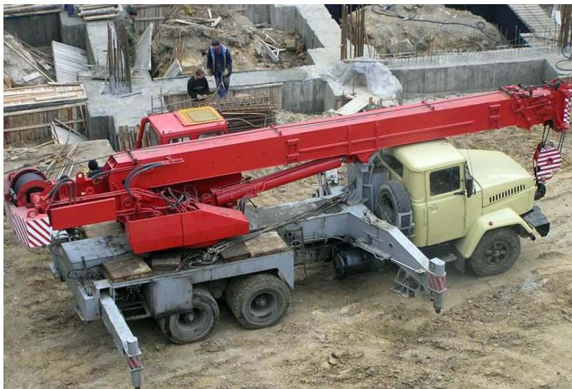
Рис. 1 – Загальний вигляд автомобільного крана КС-557 КР
